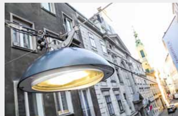
Die MA 33 in Wien geht bei der städtischen Beleuchtung innovative Wege: neue Standardleuchte in Seilhängeleuchten-Ausführung mit LED-Leuchtmittel.
