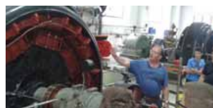
Absolventen der HTL St. Pölten und jetzige Mitarbeiter der EVN erläuterten die Geschichte und technischen Einzelheiten der historischen Wasserkraftanlage Wienerbruck.
